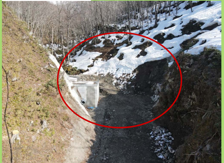
水沢第3砂防堰堤
