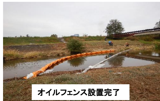
オイルフェンス設置作業
