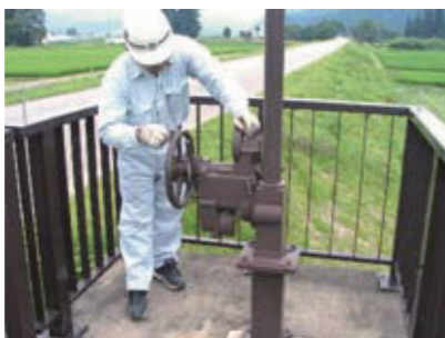
樋門設備の保守点検
