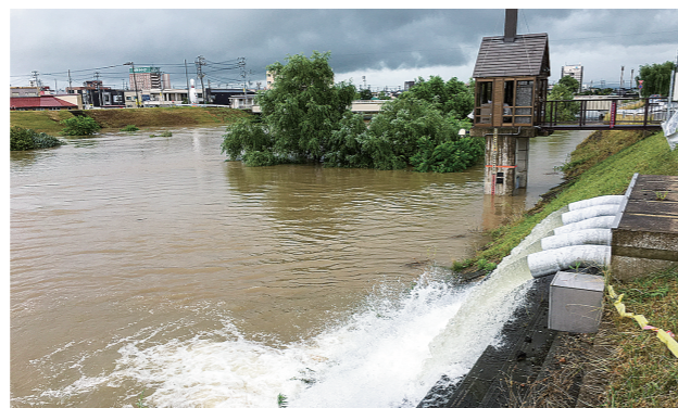
平成29年7月洪水 排水ポンプ車での排水状況 (大仙市浜町地区)
