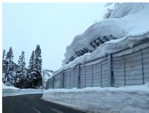
写真2 平成29年度状況写真
