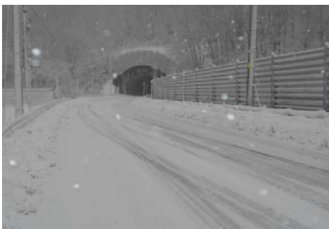
写真5 平成28年度状況写真
