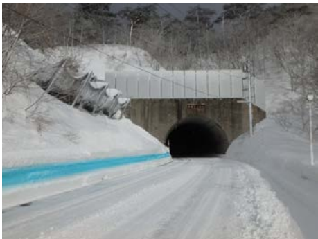
写真3 平成28年度状況写真
