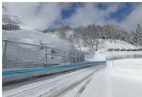
写真1 平成28年度状況写真
