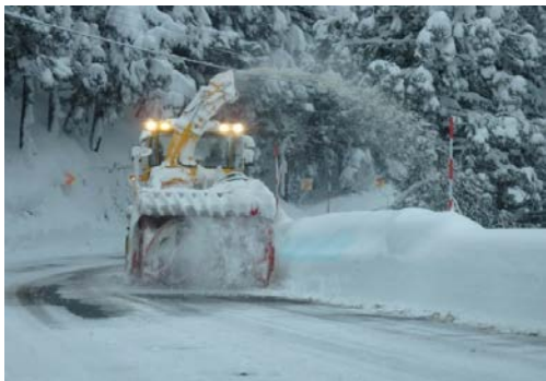
写真9 除雪状況写真
