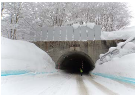
写真4 平成29年度状況写真
