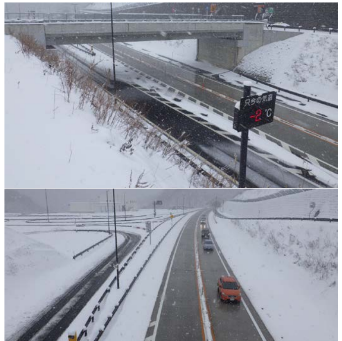
写真-1 大滝除雪ステーション付近
