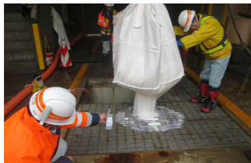
写真4. 溶解槽への投入状況
