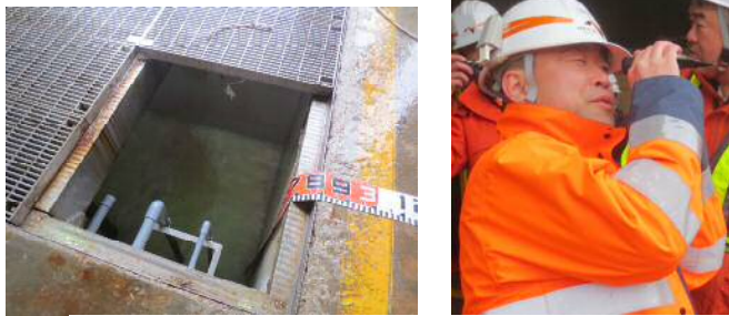
写真5. 溶液製造状況 (左) と濃度確認状況 (右)
