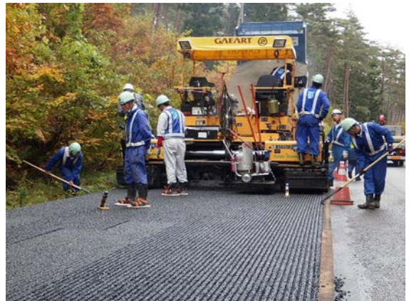
写真-3 FFP工法施工状況
