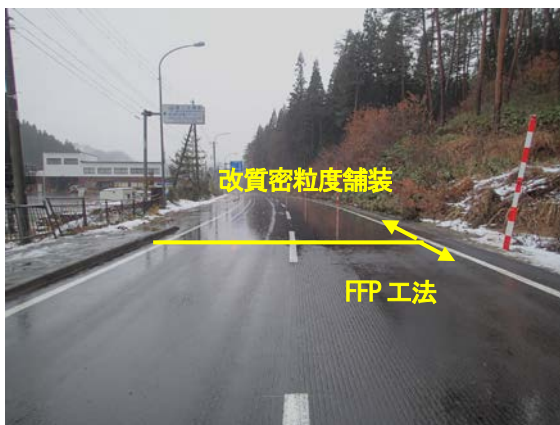
写真-4 雨水時路面状況
