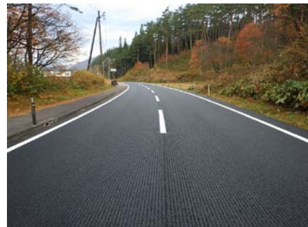
写真-2 縦溝粗面仕上げの例
