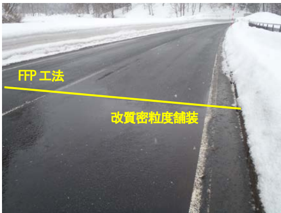
写真-5 凍結抑制剤散布後路面状況
