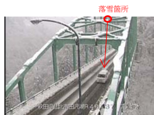
写真2 H29 車両損傷事故事例
