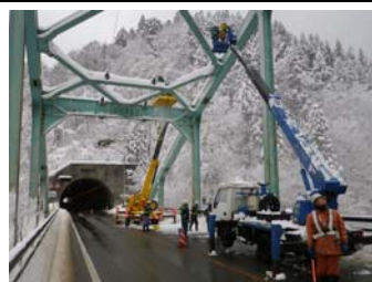
写真5 高所作業車による雪下し
