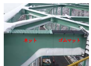
写真13 ①設置箇所拡大
