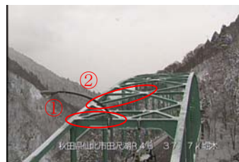
写真12 材料設置箇所(全景)
