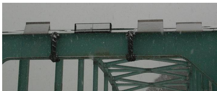
写真6 冠雪対策試験施工
