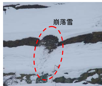
写真3 人工法面の崩落雪
