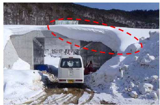
写真2 カルバートボックス部の雪底
