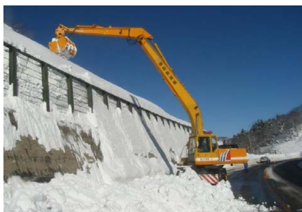
写真1 雪庇除去作業状況
