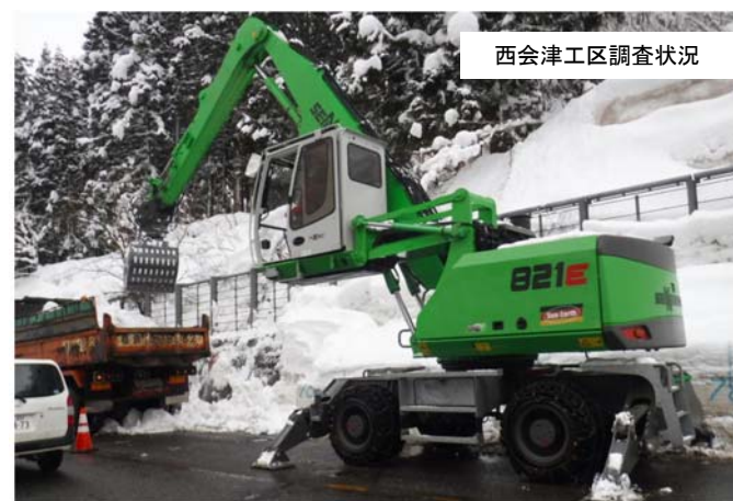
写真6 擁壁手前の積雪除去作業（選定機）
