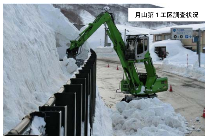
写真5 防護柵背面のポケット造成作業（選定機）
