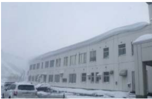
写真1 湯沢管理事務所
