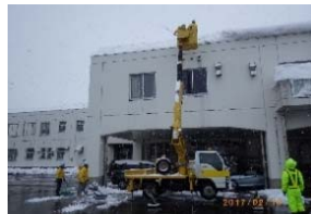
写真2 高所作業車を使用した雪庇処理
