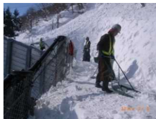
図2 除雪作業状況
