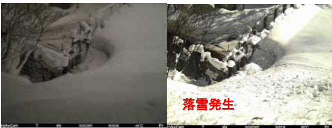
1/31 (16:53) (稼働中) 2/1 (10:57) (稼働後)
