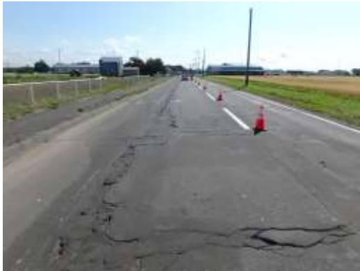
写真-3 施工前の路面状況
