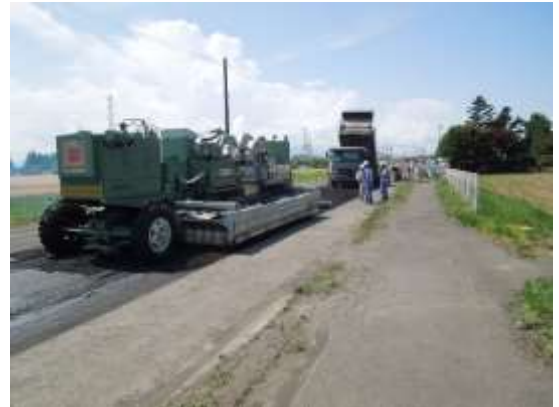
写真-4 施工状況
