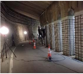
【写真5 クラック補修作業状況】
