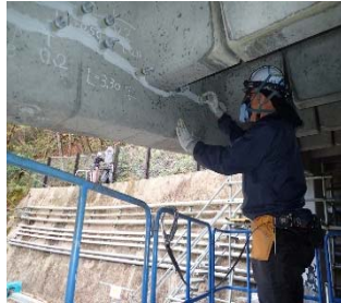
【写真5 クラック補修作業状況】
