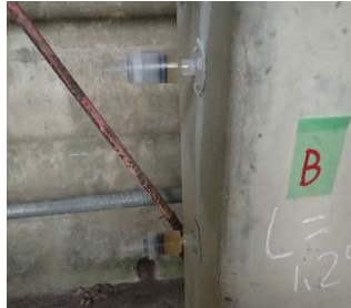
【写真5 クラック補修作業状況】
