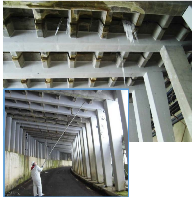
【写真1 氷柱の除去作業状況】
