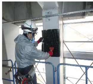
【写真5 クラック補修作業状況】
