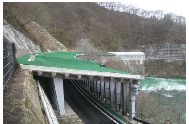
【写真10 補修後の沼尾シェッド】
