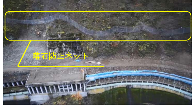
【写真7 仮設落石防止ネット】
