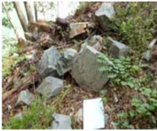
【写真3 法面上部の転石】
