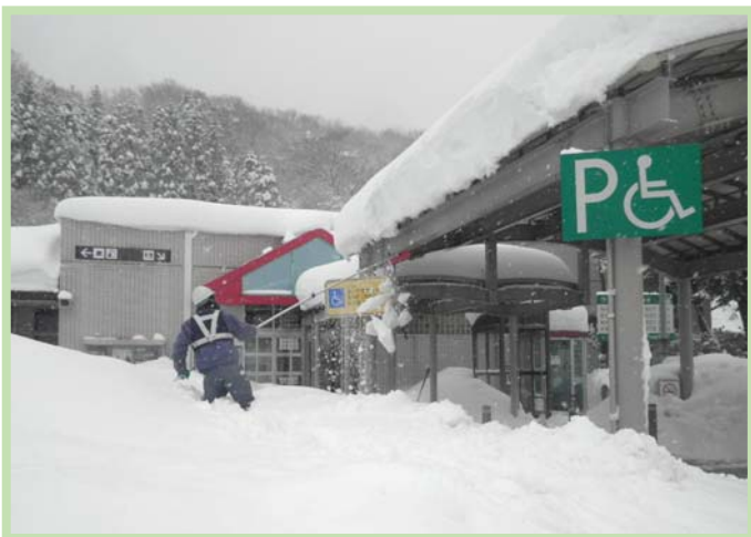
■写真-2 (雪庇処理作業状況)
