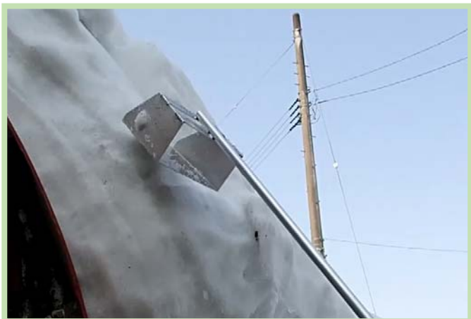
■写真-8 (「箱型タイプ」使用状況)
