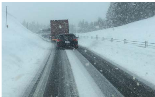
写真-4 WR部雪堤成長状況
