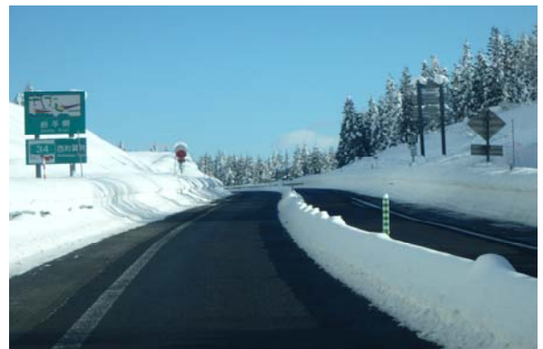
写真-2 ポストコーン部除雪状況
