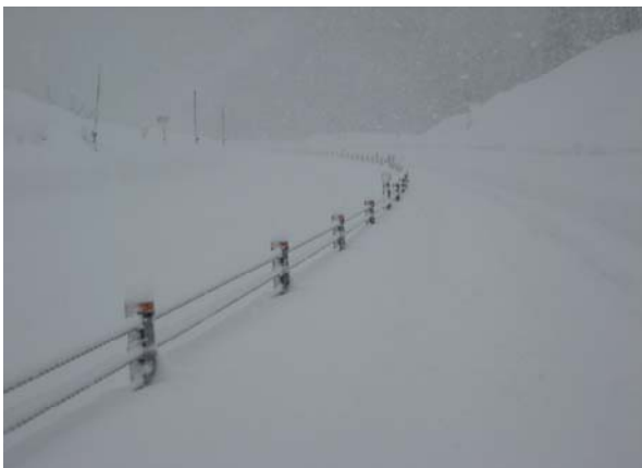
写真-8 WR部の雪堤状況
