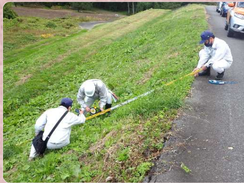
▲ 堤防勾配を測定し変状の有無を確認
