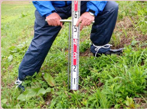
▲ 貫入棒を押し込んで、簡易的に堤防の強さを確認
