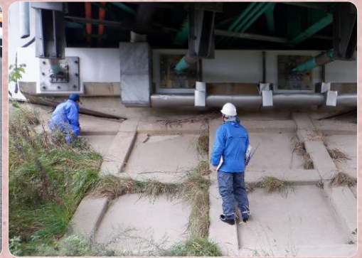
▲ 護岸に亀裂等がないかを目視で確認
