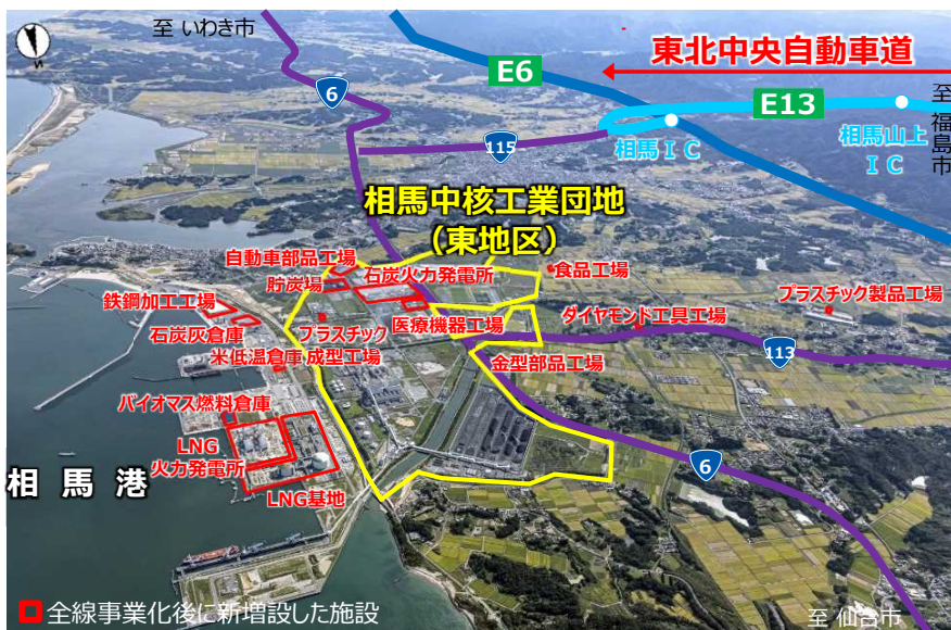
▼相馬港および周辺工業団地の企業立地状況
