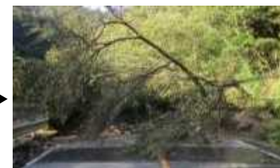
国道115号 法面崩落と倒木 ▶（R1.10.13撮影）
