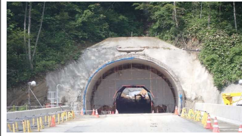
前波トンネル
