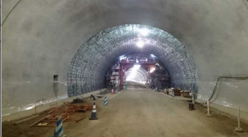
岩清水トンネル
