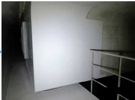
写真4-12 【対策】 桁端部の断面修復及び表面保護
