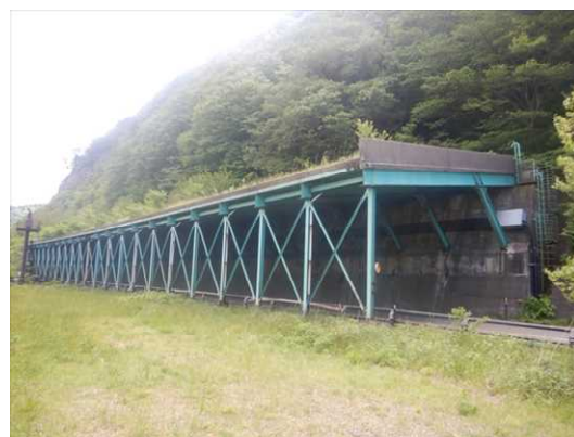
写真 4-22 【全景】清川スノーシェッド
