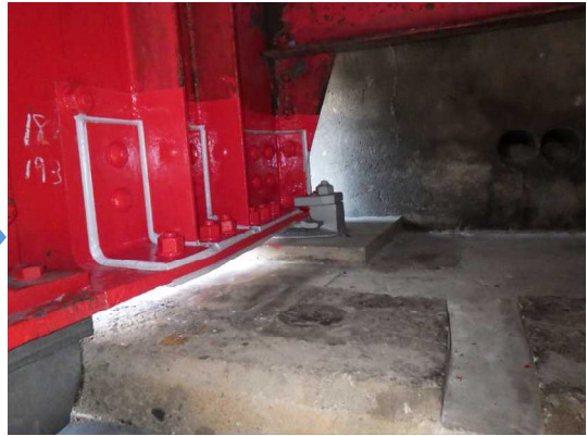
写真4-9 【対策】支承補修
