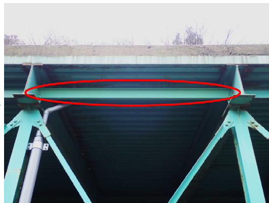
写真 4-24 【対策】横梁の部材交換
