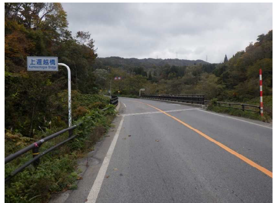
写真4-4 【全景】上遅越橋
