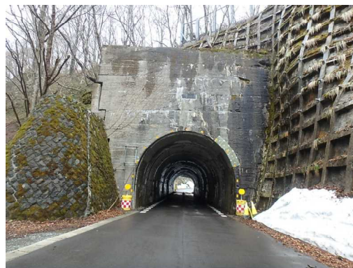
写真 4-19 【全景】青沢第一隧道 （酒田側より撮影）
