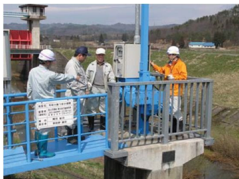
施設点検（樋門ゲート設備）の状況
