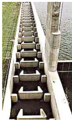
下流側から見た魚道
