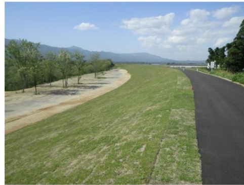
堤防補修後（堤防植生不良により、芝張替実施）
