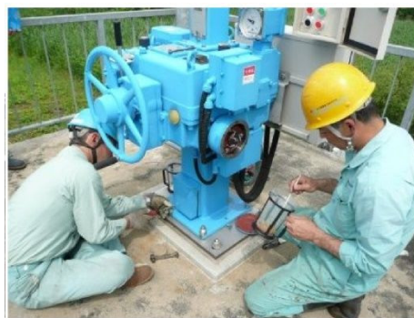
樋門樋管補修（経年劣化による開閉器補修）
