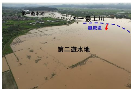
洪水時の空撮写真の撮影（平成 26 年 7 月洪水時の大久保遊水地の状況）
