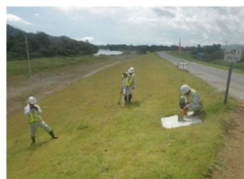
定期横断測量状況
