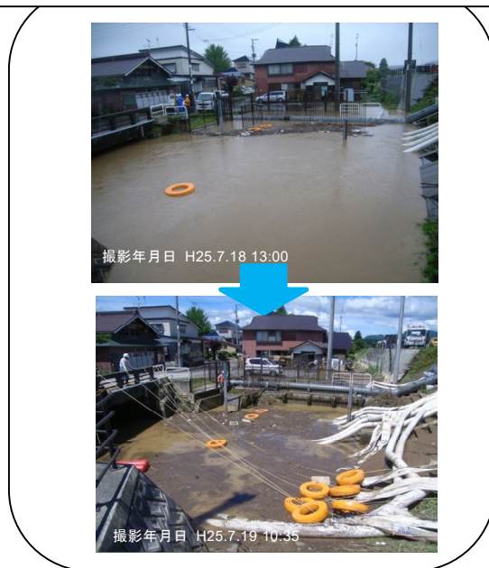
排水ピット活用例（蔵岡地区 H25.7 洪水）
