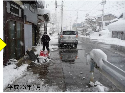
整備後（大蔵村清水）
