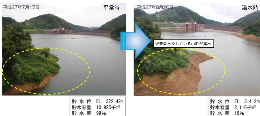
白川ダム貯水状況
