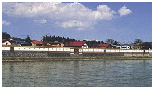
大石田特殊堤修景
