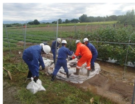
漏水による水防活動状況 (釜段工法)
