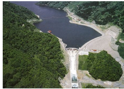
寒河江ダム (平成 3 年完成)
