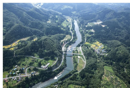
荒砥狭窄部を流下する上流部
