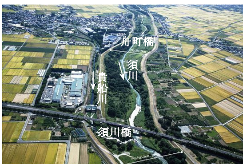
須川鉄道橋付近の樹木状況
