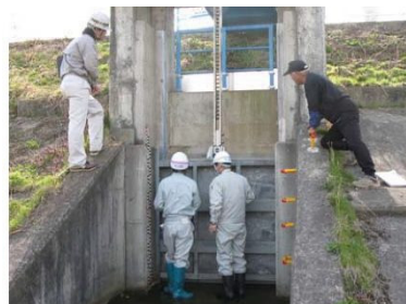
樋門・樋管の点検状況
