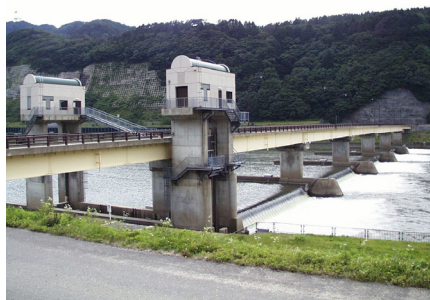
最上川さみだれ大堰
