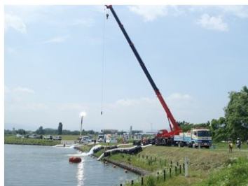
内水排除訓練
