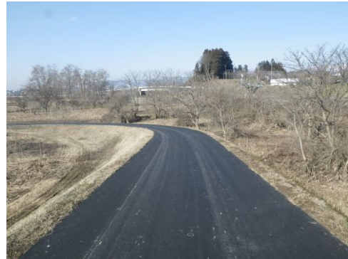
堤防の天端舗装補修後の状況
