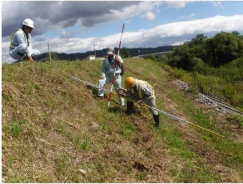
除草後の堤防点検
