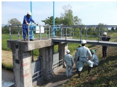
樋門樋管点検
