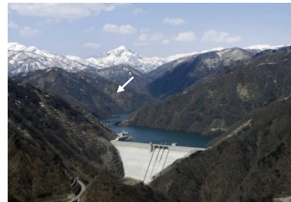
長井ダム (平成 23 年完成)
