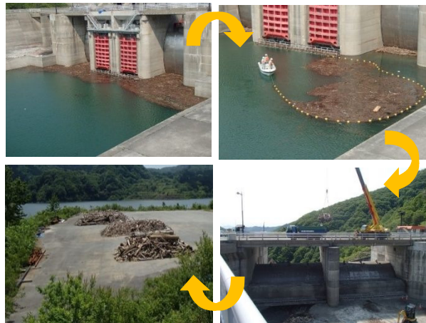
寒河江ダム流木収集状況及び処理状況
