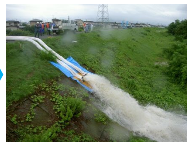
排水ポンプ車による排水 (王川排水樋門)
