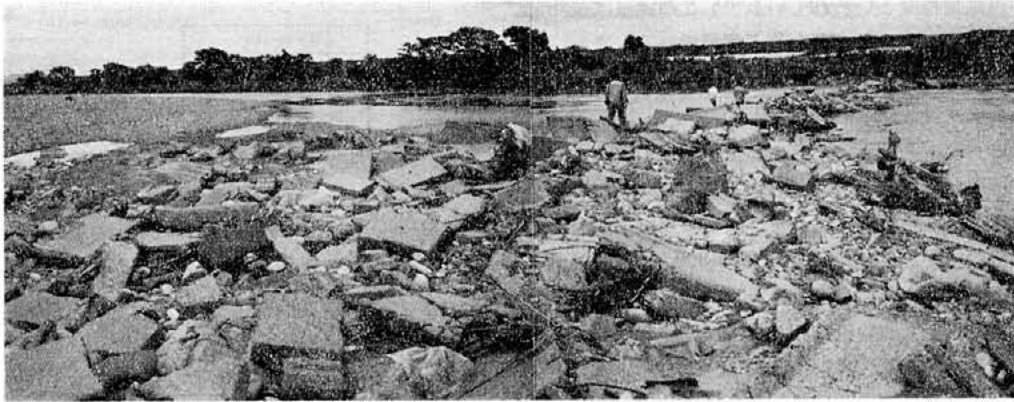
写真一 旧三郷堰床固め(旧三郷堰取水口が写真右上に位置している)
