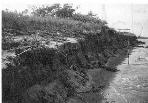
写真-16 砂州フラッシュ後の上流側の移行部 (1990年6月30日撮影)
