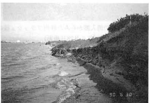
写真-14 砂州フラッシュ後の上流側の移行部 (1990年6月30日撮影)
