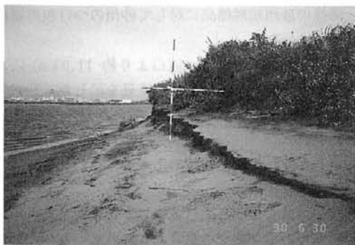
写真-12 砂州フラッシュ後の下流側の移行部 (1990年6月30日撮影)
