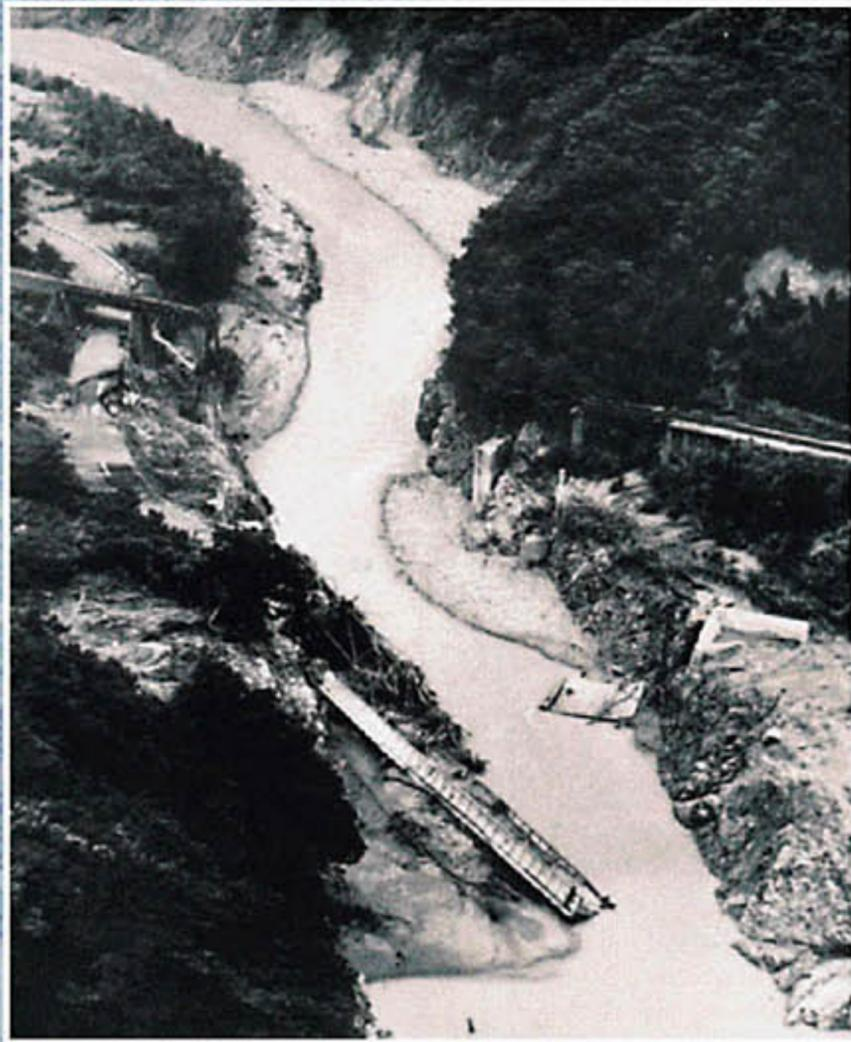
国鉄荒川第三鉄橋とともに落橋した中野橋
