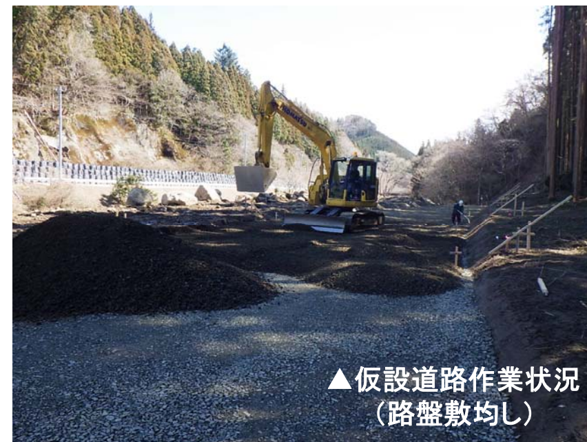
▲仮設道路作業状況 (路盤材締固め)
