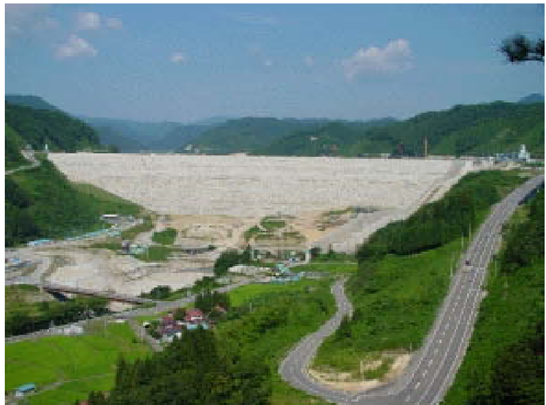
堤体盛立完了(平成14年7月) <下流から見たダム堤体>
