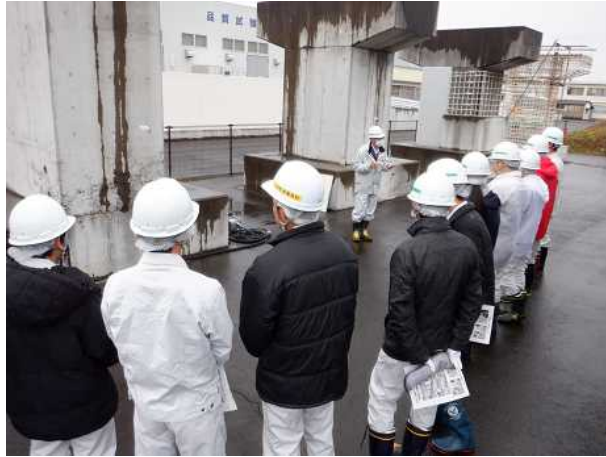
不適切施工について
