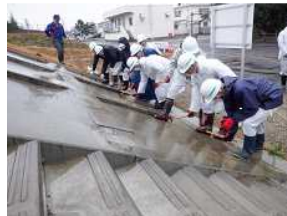
打音による護岸の空洞化の確認
