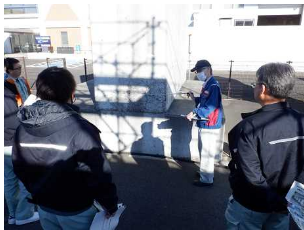
不適切施工について
