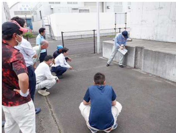
不適切施工について
