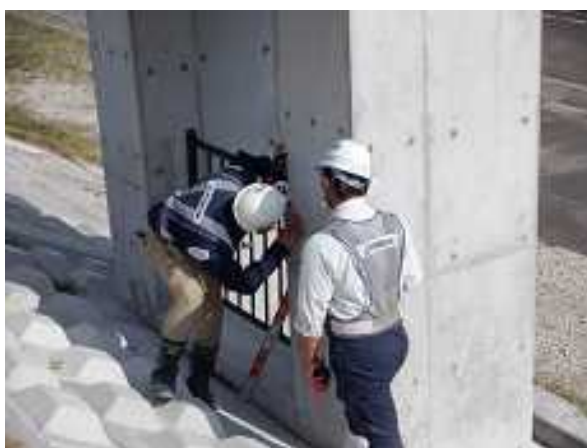
樋門門柱の傾斜状況の計測
