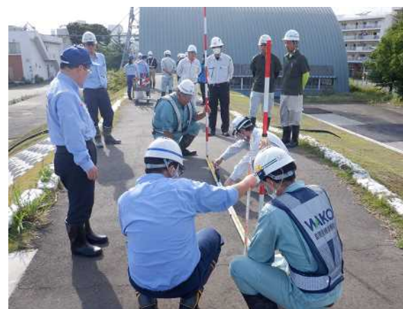
堤防の抜け上がりの計測
