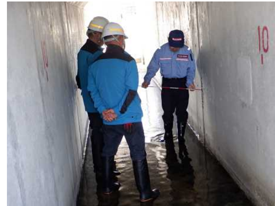
樋管函体内部の変状確認
