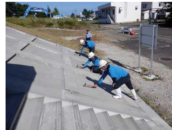
打音による護岸の空洞化の確認
