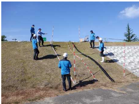
堤防のはらみ出し・寺勾配の計測
