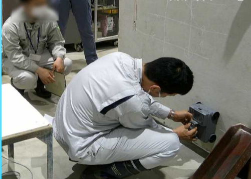
【実習② 非破壊試験による品質管理】
