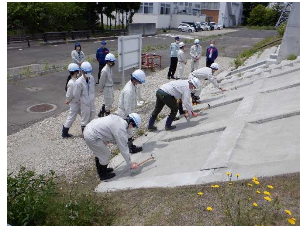
打音による護岸の空洞化の確認
