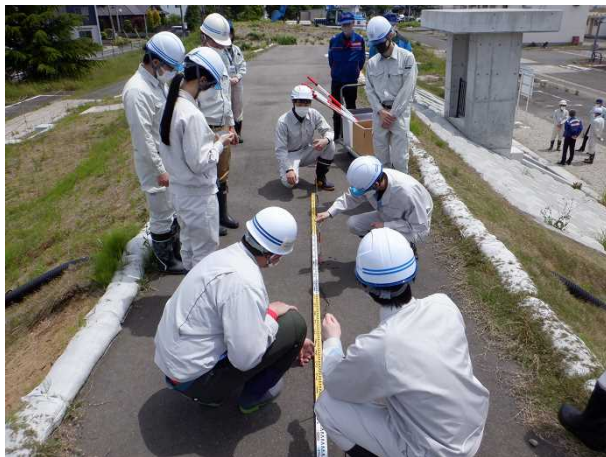
堤防の亀裂の計測
