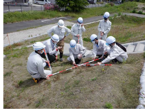
堤防の陥没の計測
