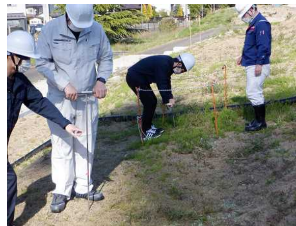
貫入棒による堤防の締固め度の簡易判定
