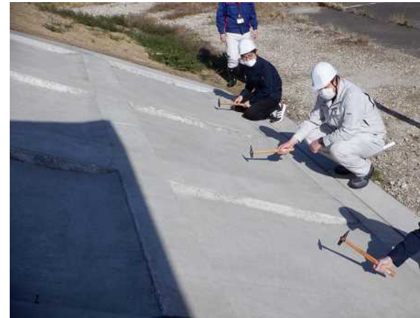
打音による護岸の空洞化の確認
