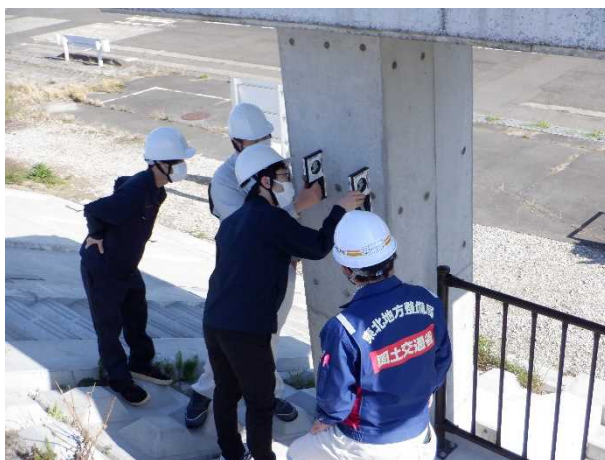
樋門門柱の傾斜状況の計測
