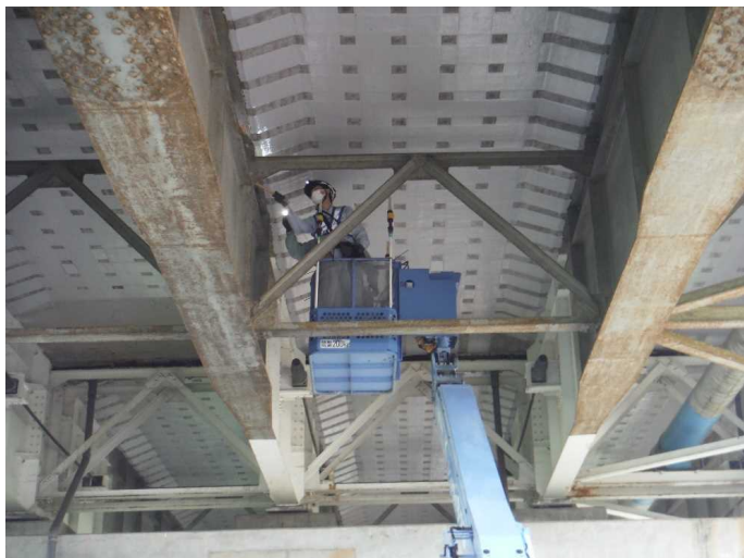
▲橋梁点検の様子
