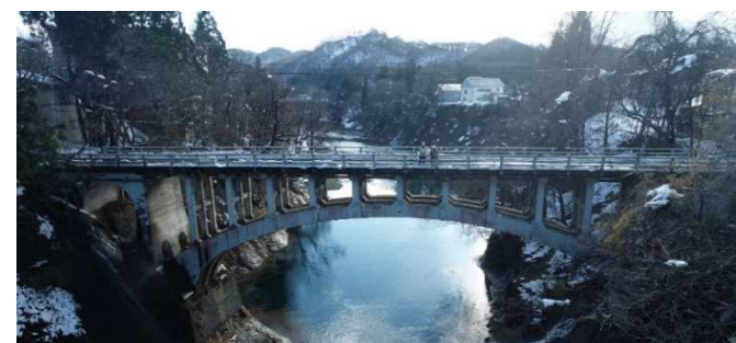
コンクリートアーチ橋
