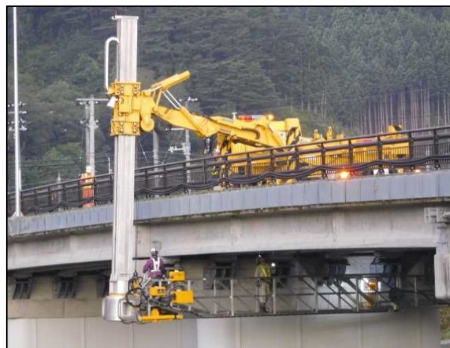
道路橋の点検・診断、予防保全対策の検討
