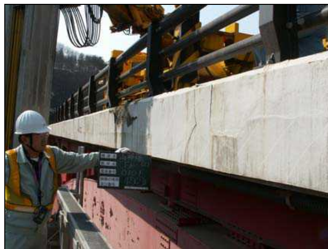
道路橋の点検・診断、予防保全対策の検討
