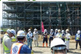
現場点検の様子
