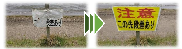
【小川原湖公園】注意段差有り看板の劣化
