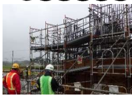
【現場点検：天間林道路】
