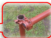
【単管柵への保護キャップの設置】
