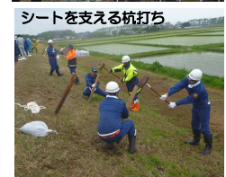
堤防法面へのシート張り工
