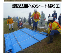
堤防法面へのシート張り工
