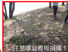
注意喚起看板損傷1
