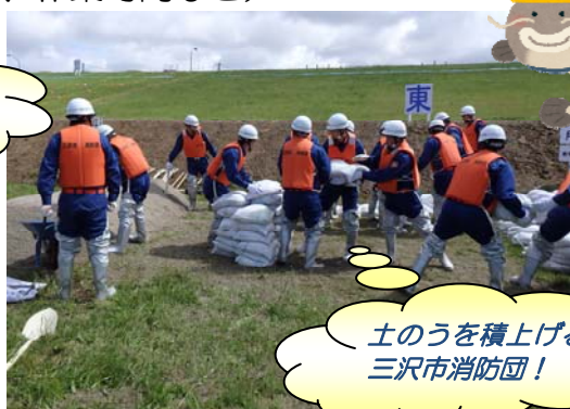
▲月の輪工の作業
