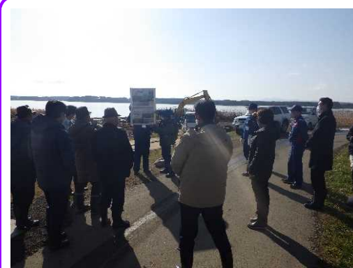
七戸川河口部河道掘削工事視察の様子
