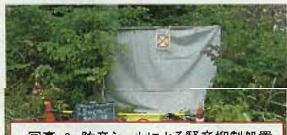
写真-2 防音シートによる騒音抑制処置
