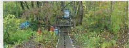
写真-1 特装車運搬ルートの桟橋設置
