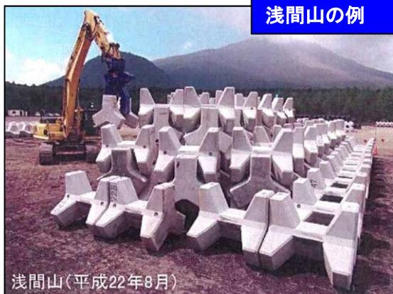
ブロック積による導流堤（浅間山での施工訓練）
