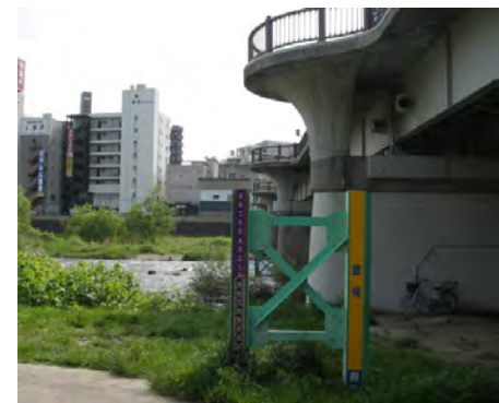
危険水位表示板（広瀬橋）
