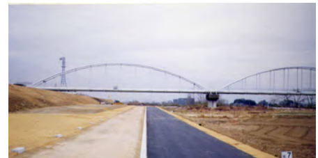
緊急河川敷道路
