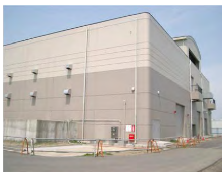
長町第一ポンプ場 (仙台市下水道)
