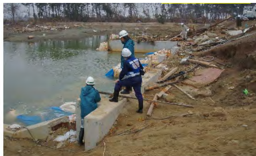
TEC-FORCE の派遣状況 (H23.4.11 井土浦川付近)
