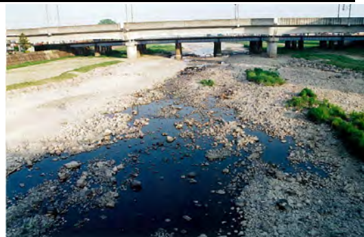
平成6年渇水時写真(広瀬川)
