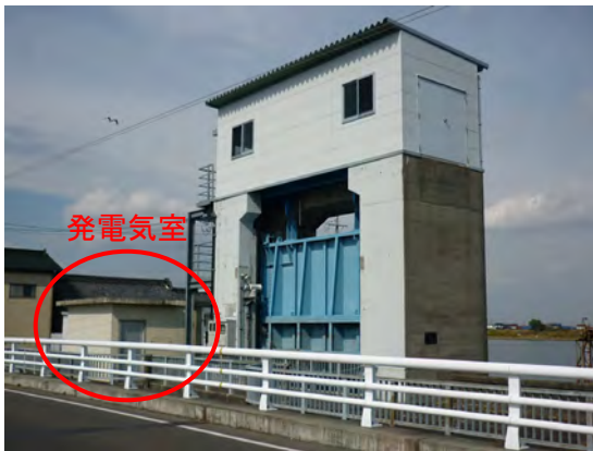
閉上水門(地震前)
