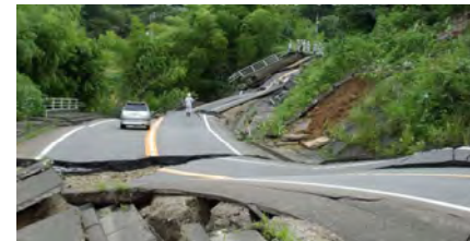
被災状況調査
