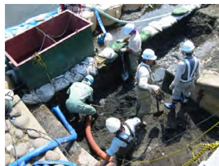
取水ポンプ場土砂撤去作業
