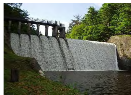
青下第二ダム
