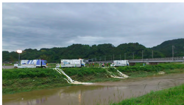
排水ポンプ車の活動状況
