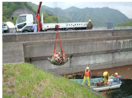
釜房ダム 流木処理
