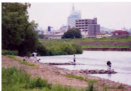
環境及び親水性に配慮した水制工
