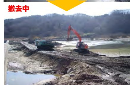
土砂撤去の状況(貯砂ダム)
