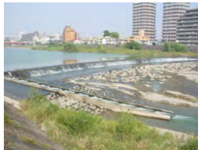
郡山堰（広瀬川 4k 地点）
