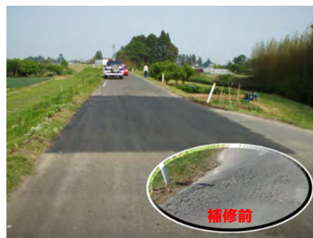
広瀬川堤防天端舗装状況
