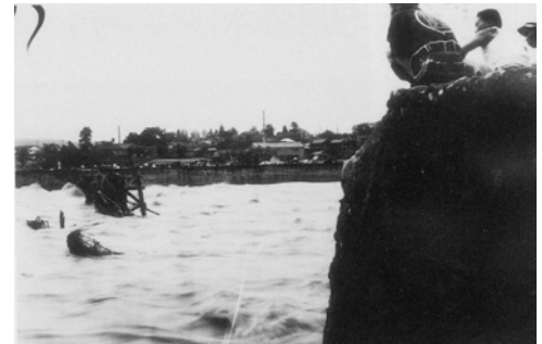
評定河原橋の流出
