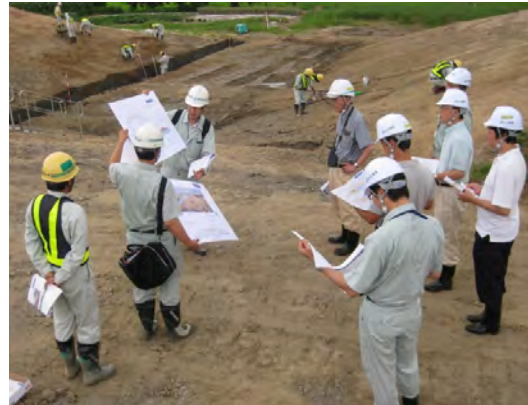
堤防被災の原因調査状況
