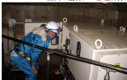
放流設備の点検
