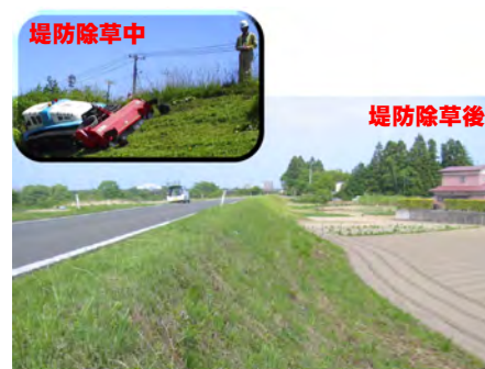
堤防の除草状況
