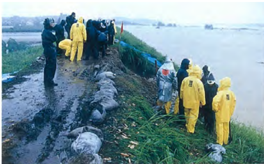
S61.8洪水 藤塚地区法崩れの状況
