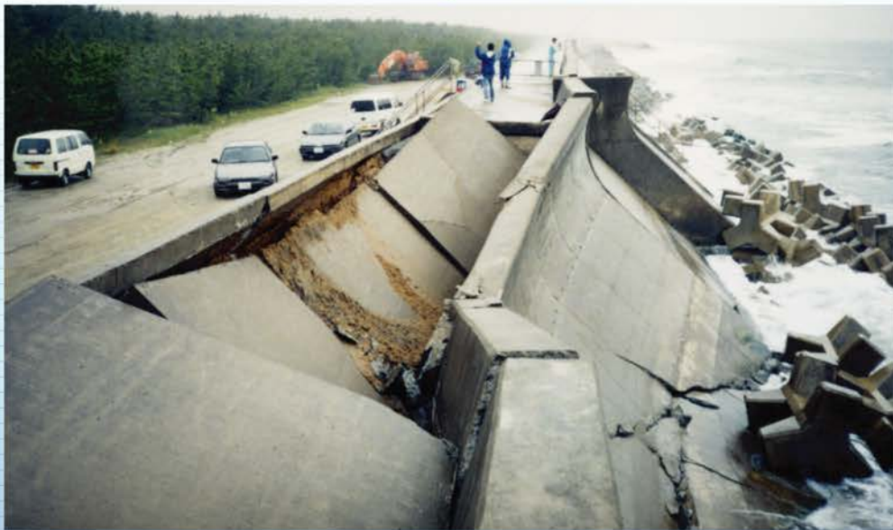
砂浜が浸食され、消波ブロックが沈み、海岸堤防が被害を受けた。(平成3年撮影)
