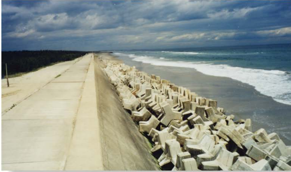
海岸堤防を守るために、海岸堤防前面にブロックが設置されている。(平成元年撮影)
