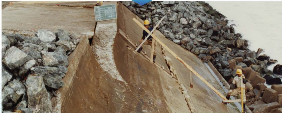
砂浜がなくなり、海岸堤防が被害を受けた。(昭和57年撮影)
