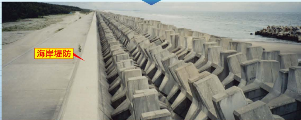
現在は砂浜がなく、海岸堤防を守るため、前面に消波ブロックが設置されている。
