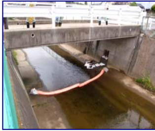
オイルフェンスの設置
